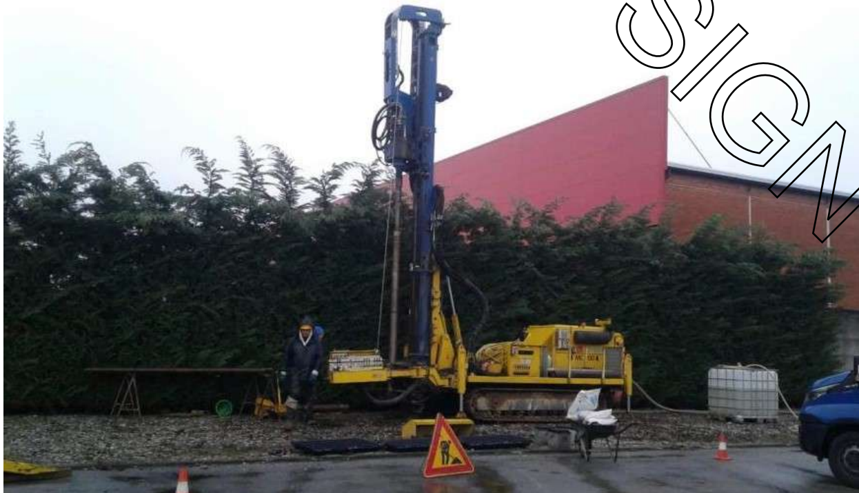
Fig.5 La trivellazione dei piezometri per il controllo della falda
